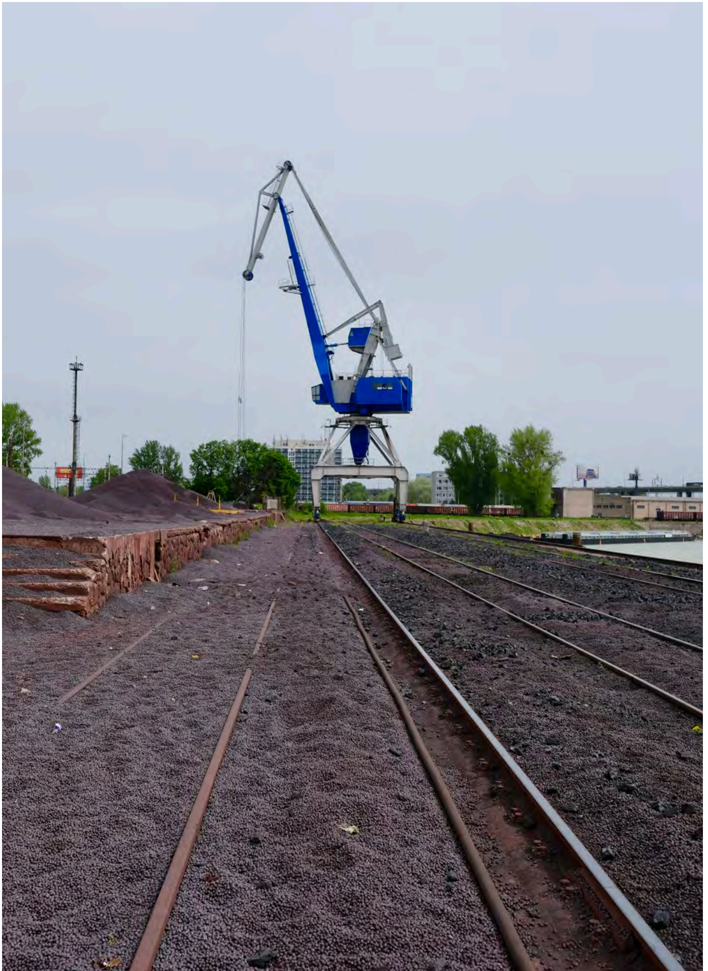
Obrázok 8: Existujúce industriálne prvky v Zimnom prístave – prekládkový žeriav, koľaje a peletizovaná ruda
